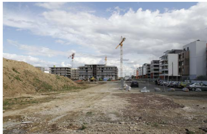
2012 - Les terres excavées sont stockées sur la Piste
